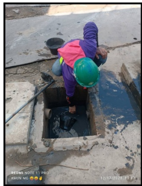
รูปที่ 78(ต่อ) คนงานทำความสะอาดบ่อดักตะกอน
