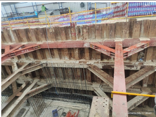
รูปที่ 21 การติดตั้ง Sheet Pile
