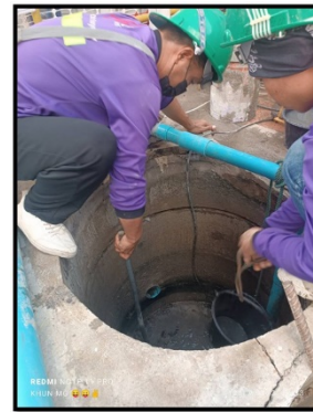
รูปที่ 78 คนงานทำความสะอาดบ่อดักตะกอน
