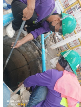
รูปที่ 78(ต่อ) คนงานทำความสะอาดบ่อดักตะกอน
