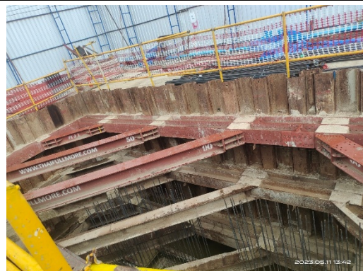
รูปที่ 21 การติดตั้ง Sheet Pile
