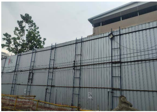
รูปที่ 1 รั้ว Metal Sheet รอบพื้นที่โครงการ
